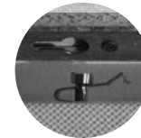
Le téton s'enclenche dans le rail fixé au plafond
