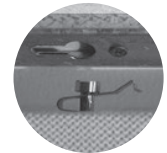
Der Noppen wird in der Deckenschiene verankert.
