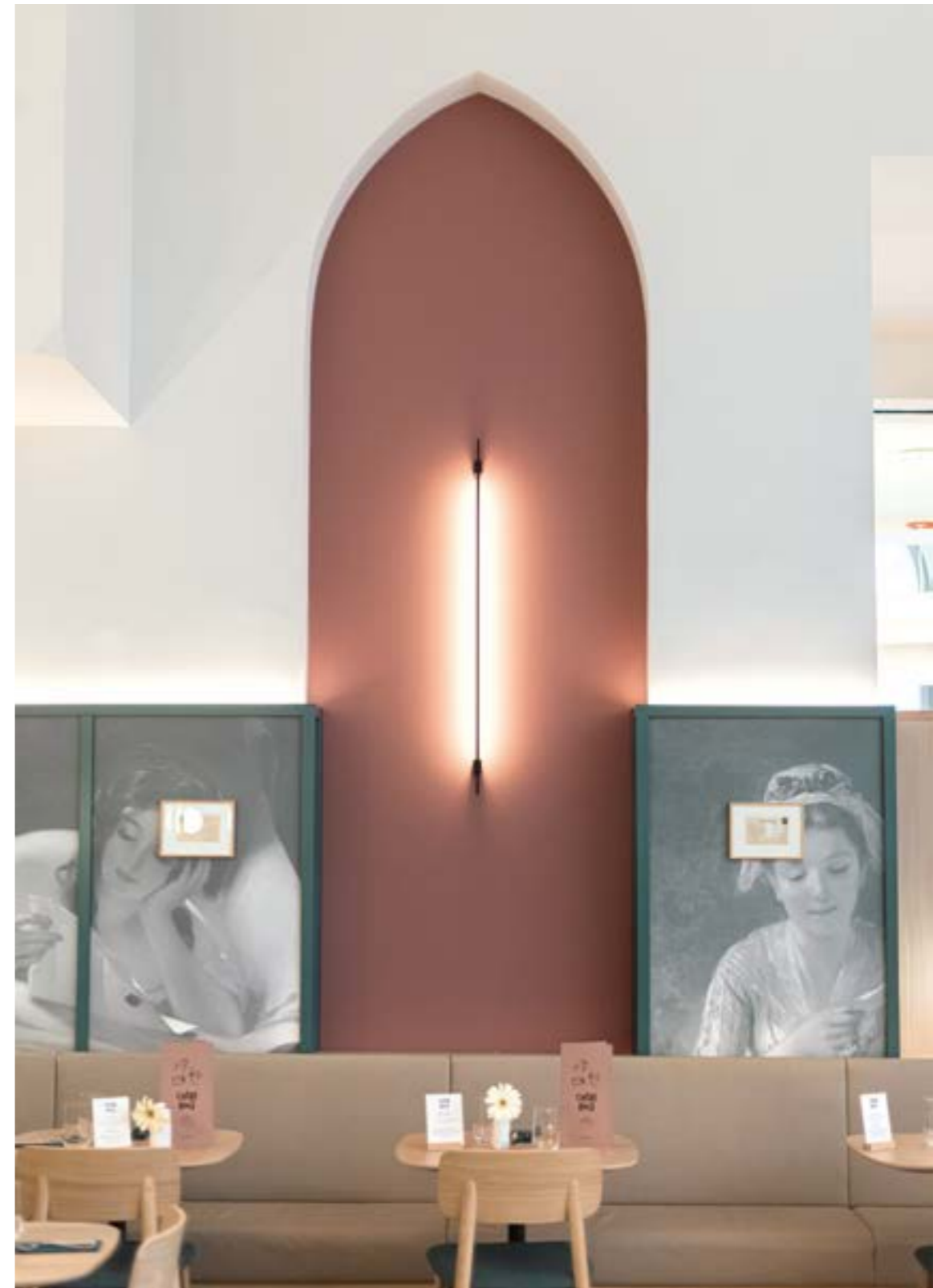
Hintergrund einer Wandnische aus Akustikverkleidung Vibrasto. Die Spannleisten passen sich der baulichen Form perfekt an. Brasserie „Chère Amie“, Straßburg, Design: Pascal Claude Drach, 2023.
