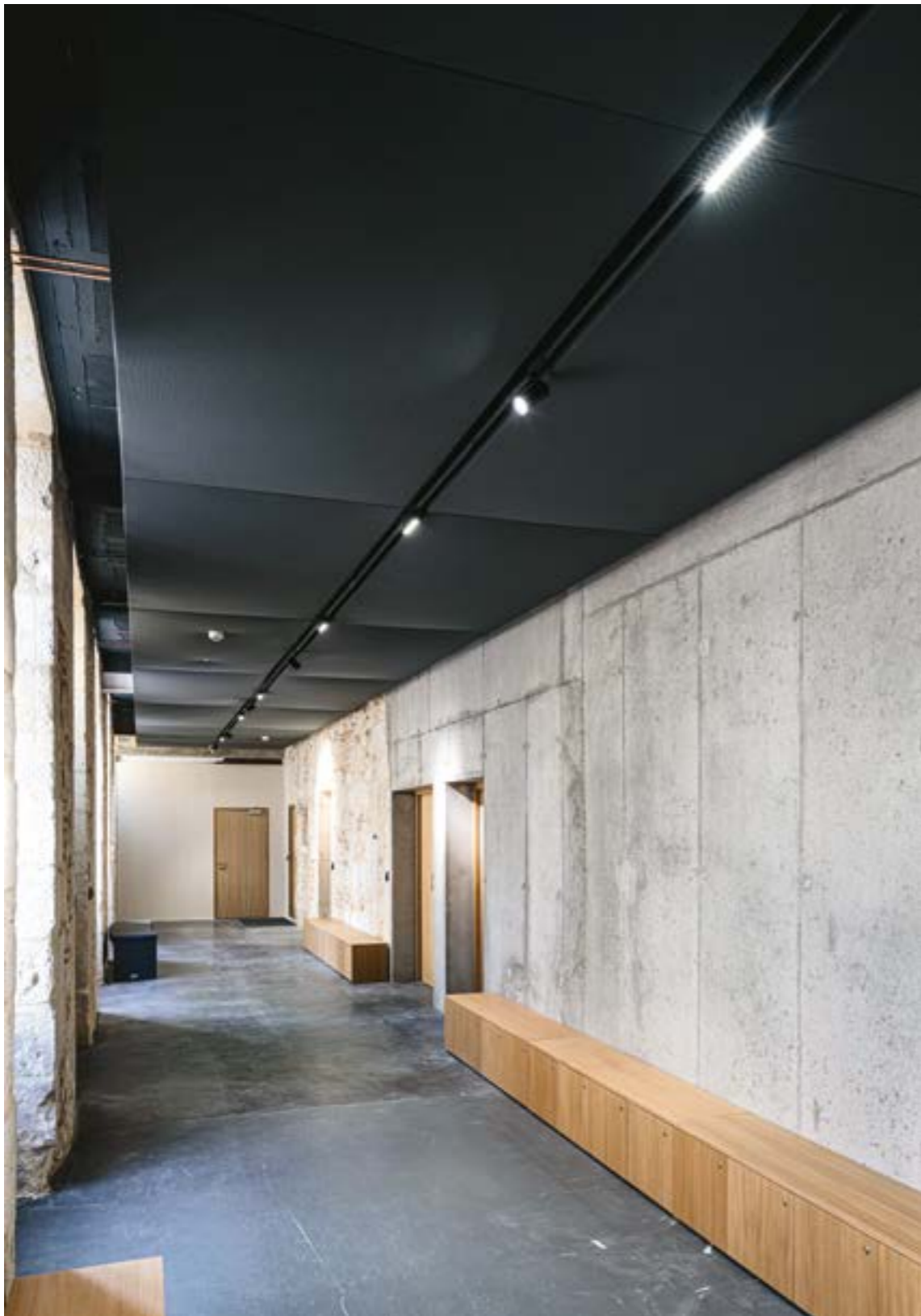
Deckenfläche Strato mit integrierter Beleuchtung. Der Abstand zwischen zwei Paneelen Stereo wird durch Verbindungsstege einfach und präzise geregelt (siehe S. 109). Die mittig ausgebohrten Verbindungsstege sind für die Fixierung von Leuchtschienen vorgesehen. Centre d'interprétation de l'architecture et du patrimoine (Ciap), Bergerac (Frankreich). Architekturbüro Comin-Campguilhem, 2023.
