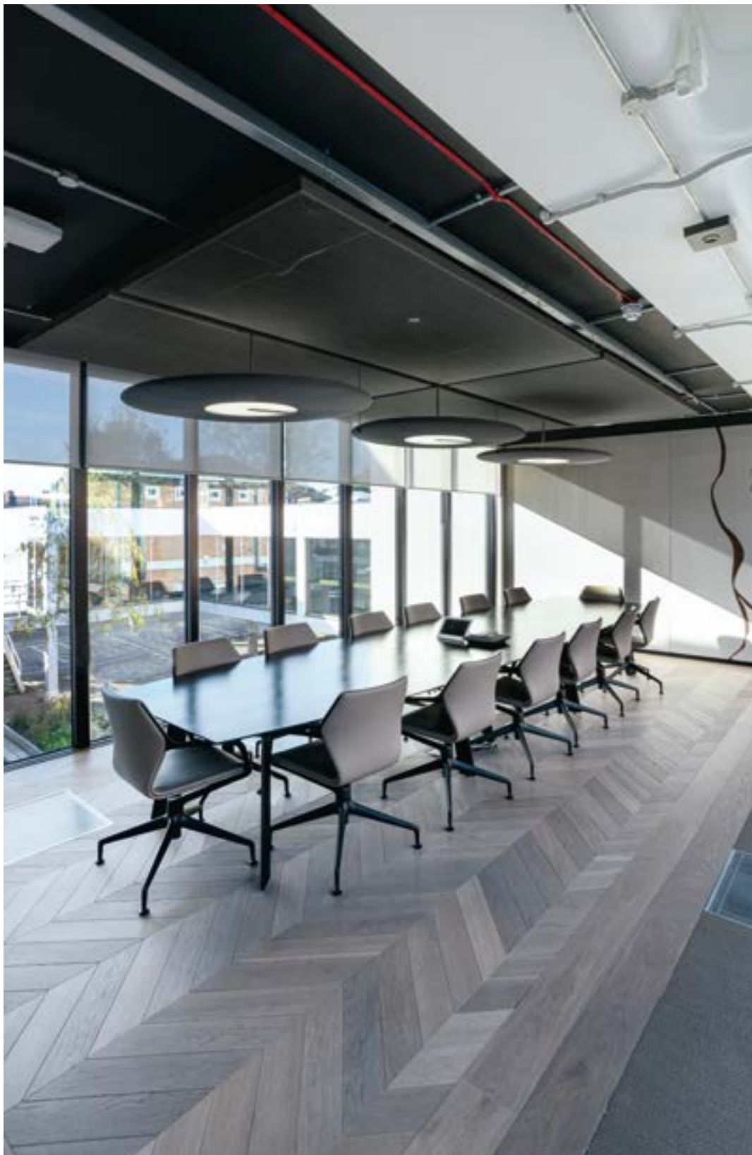
Deckenverkleidung aus abgehängten transparenten Paneelen Stereo Air. Sitz des Unternehmens William Grant & Sons, Richmond (Großbritannien). ESA (École Spéciale d'Architecture), 2021.
