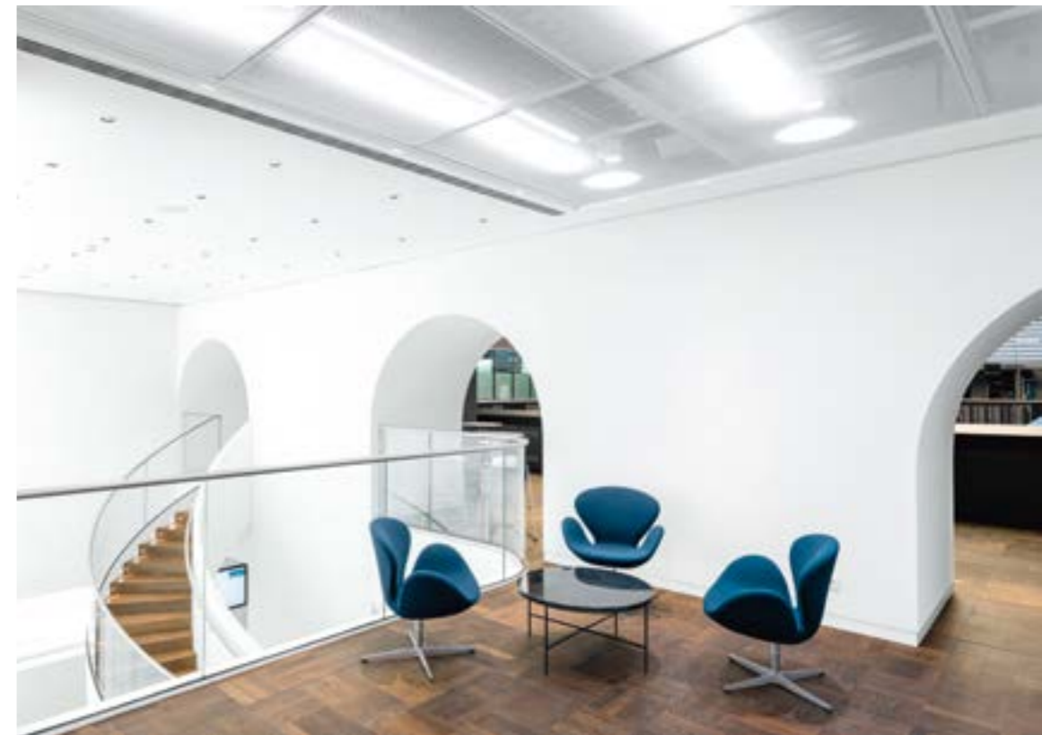
Decke Strato aus transparenten Paneelen Stereo Air, die dezent die Rauchmelder und das Rohrsystem der Klimaanlage kaschiert, das Licht aus den Beleuchtungen aber durchfiltern lässt. Es entsteht eine einheitliche Deckenstruktur. X-Lounge, Deutsche Börse Frankfurt am Main, Kontext Architektur, 2023.
