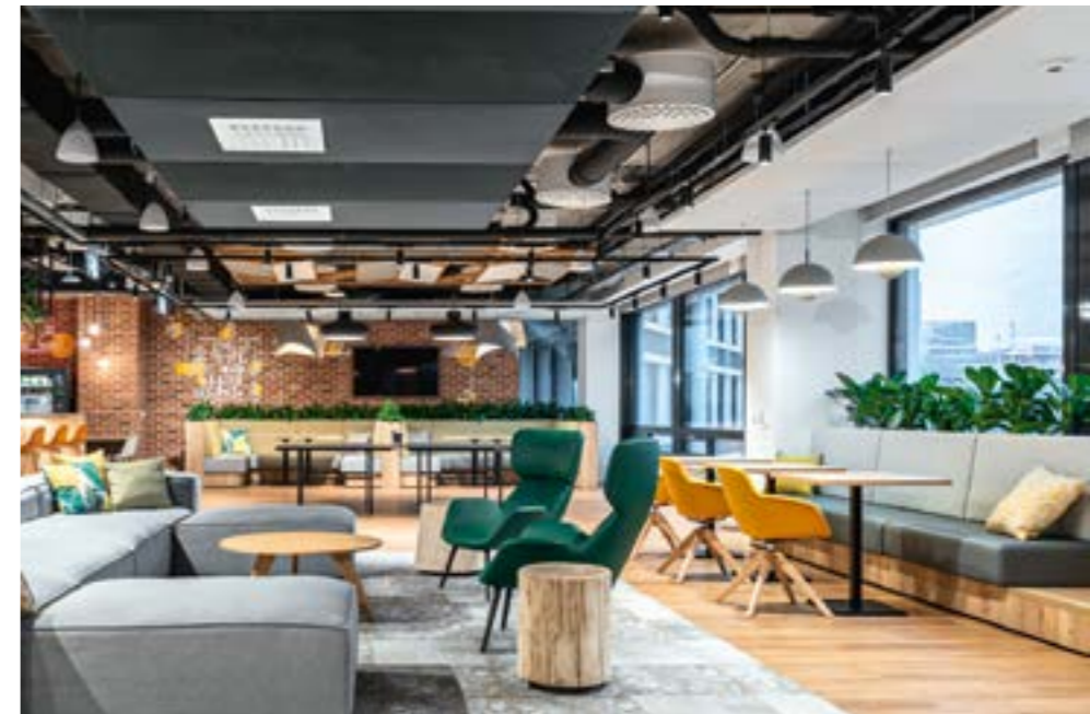
Decke Strato aus Akustikpaneelen Stereo und eingebettetem Belüftungssystem. Bürohochhaus bp Hungary, Budapest (Ungarn). DVM group, Projektmanagerinnen für die Innenarchitektur: Ida Kiss und Tímea Tóth, 2020.
