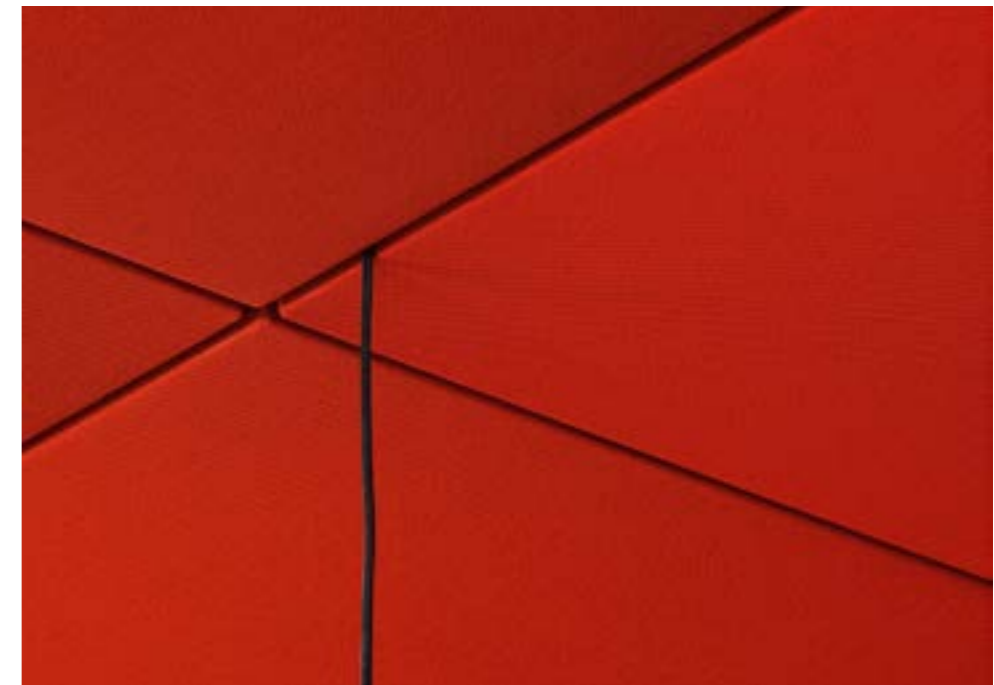
Die Stahlrahmenstruktur und die von Hand aufgezugene, ziehfähige Textilhülle Aeria gestatten perfekt gefittete geometrische Figuren.
