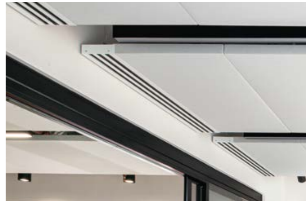
Die Lüftungsgitter werden den Außenseiten der Akustikpaneele Stereo nahtlos angepasst.
