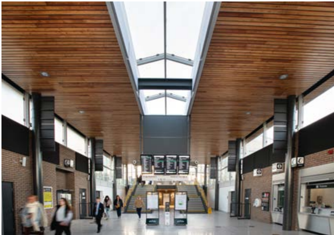
Wandbefestigte Akustikpaneele Stereo. Bahnhof Worcestershire Parkway, Architekturbüro Mott MacDonald, Projektleitung Mark Alton, 2021.
