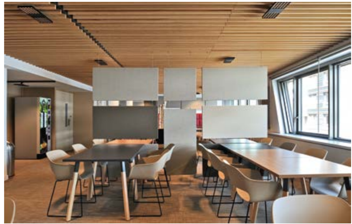
Akustikpaneele Stereo als Raumteiler, mittels durchgehender Drahtseile an Decke und Boden befestigt. Sitz der Region im Stadtteil Confluence, Lyon. FERRAND-SIGAL Architectes & Associés, Akustik: EAI, 2022.
