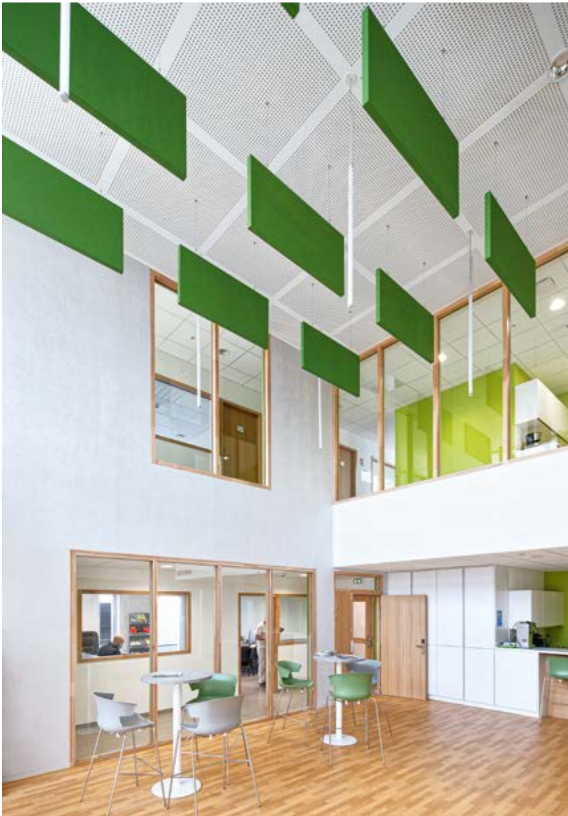
Deckenabgehängte Akustikpaneele Stereo als Baffeln. Verwaltungszentrum des SEVADEC (Syndicat d'élimination et de valorisation des déchets du Calaisis). Calais, Architekturbüro Polynôme, 2020.
