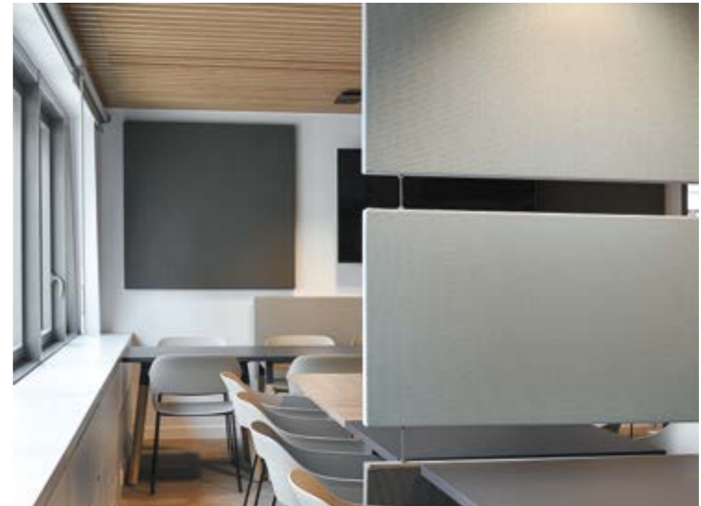
Akustikpaneele Stereo als Raumteiler, mittels durchgehender Drahtseile an Decke und Boden befestigt, dahinter mit Magnetsystem an der Wand befestigte Akustikpaneele Stereo. Sitz der Region im Stadtteil Confluence, Lyon. FERRAND-SIGAL Architectes & Associés, Akustik: EAI, 2022.
